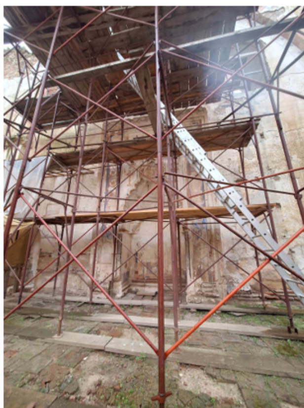
Εσωτερική όψη, πλευρά 3, μικρόμπ. πυλ. πηγή: φωτ. αρχείο ΔΣΑΝΜ 2024
