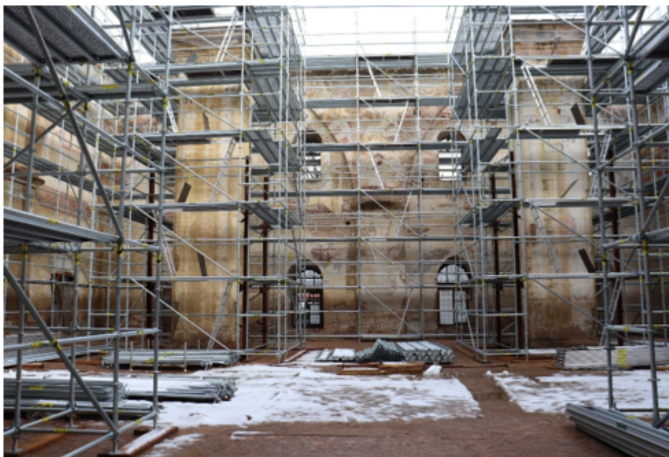
Εσωτερική όψη, πλευρά 4: πηγή: φωτ. αρχείο ΔΣΑΝΜ, 2025
