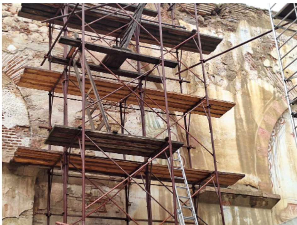
Εσωτερική όψη, πλευρά 3 μικρόμπ. πυλ. πηγή: φωτ. αρχείο ΔΣΑΝΜ 2024
