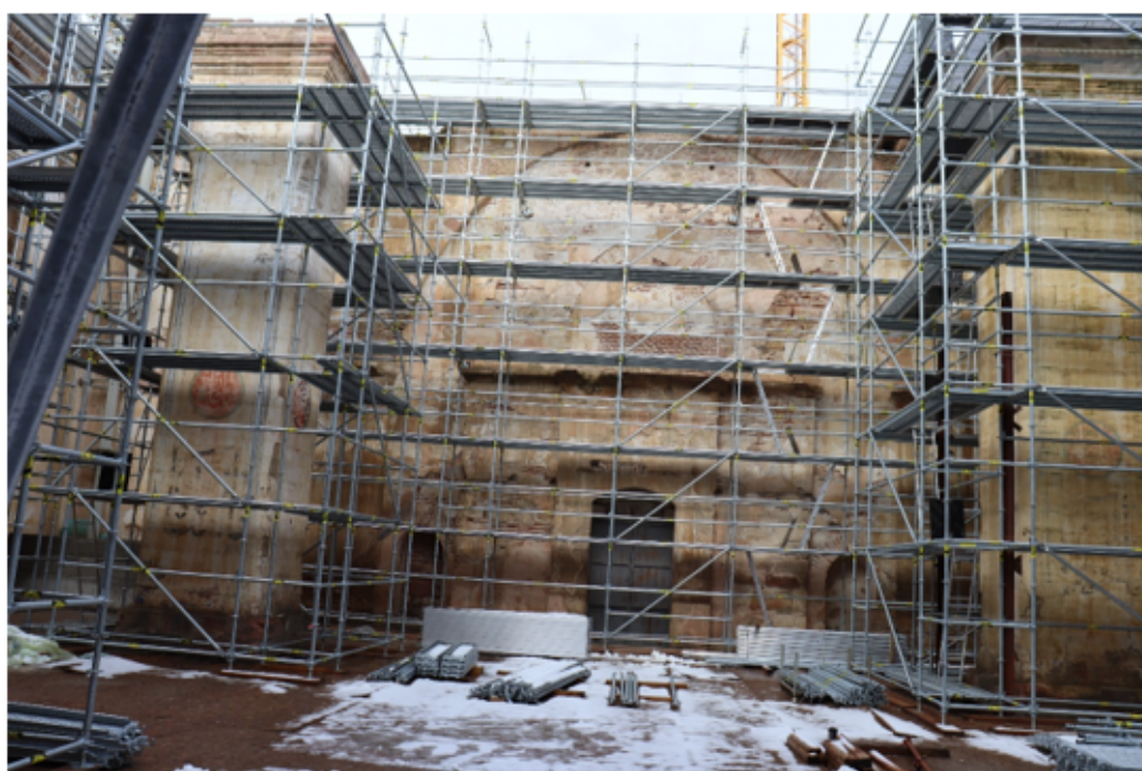
Εσωτερική όψη, πλευρά 1: πηγή: φωτ. αρχείο ΔΣΑΝΜ, 2025
