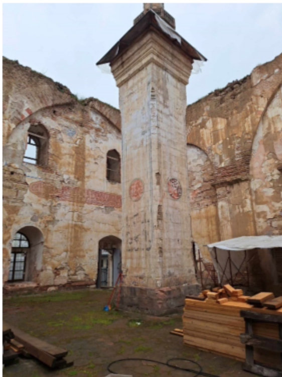
Εσωτερική όψη, άποψη τμημάτων πλευρών 1, 2 και πεσσού 1: πηγή: φωτ. αρχείο ΔΣΑΝΜ, 2024
